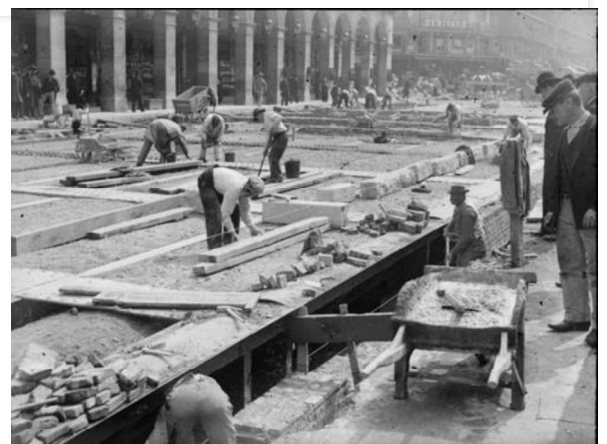
Foto: Bau der Rue du Rivoli
