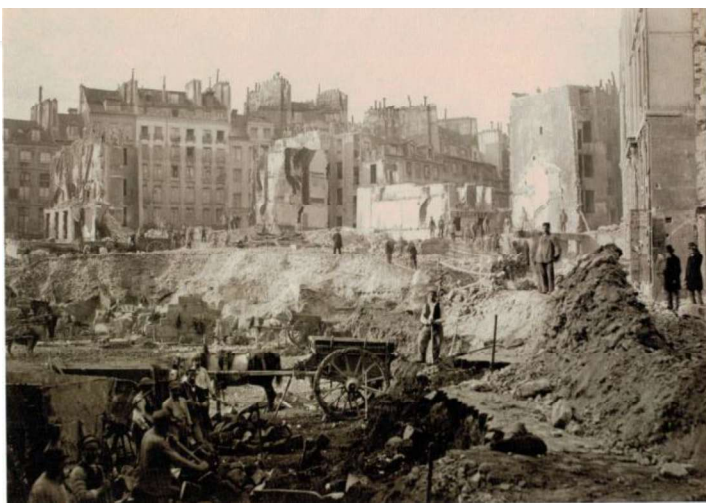
Foto: Baustelle Rue de l'Echelle/Rue Saint Augustin
